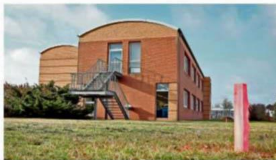
Die Pflöcke für den Erweiterungsbau, der hinter den vorhandenen Bestandsbau gesetzt wird, sind schon eingeschlagen.
